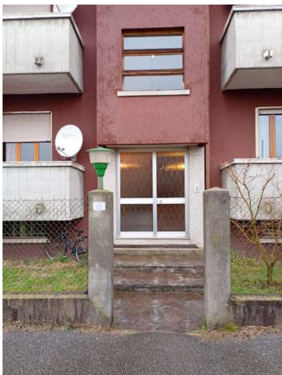
3) Ingresso all'androne delle scale/ascensore,
