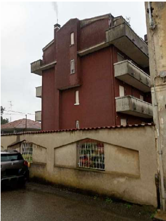
2) Veduta del fabbricato dalla strada,
