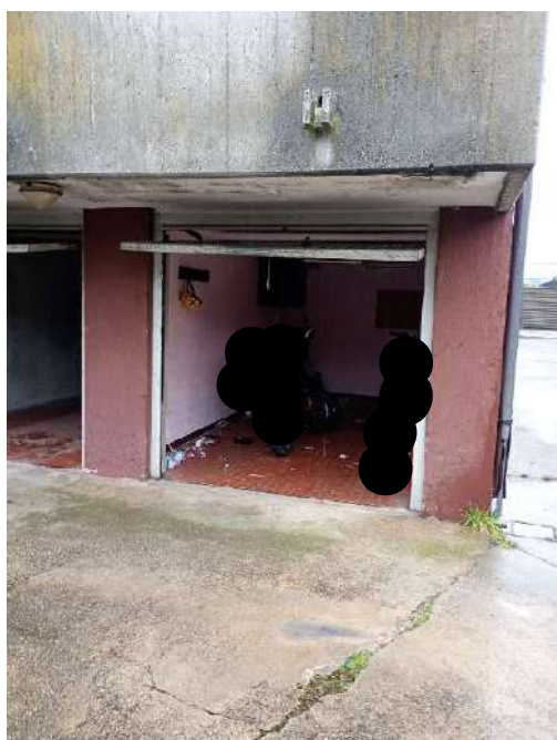
24) Box a piano Semi-interrato,
